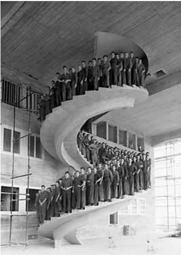
Belastungstest 1953. Neue Treppe im Belastungstest mit den Lehrlingen beim Wohlfahrtshaus für Arbeiter der BBC.
